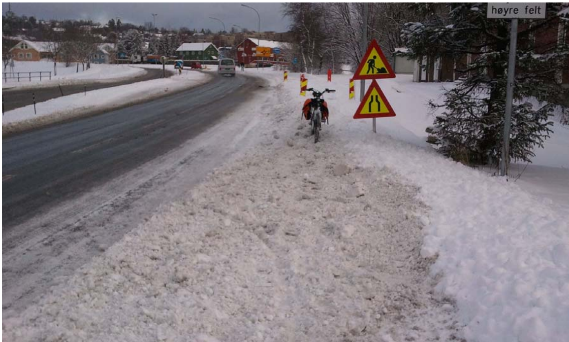
Figur 2: Resultatet: Arealet til de mye trafikantene har blitt brøytet om morgenen, men etterrydding av kjørefelt midt på dagen i.f.m. salting fører til at saltholdig snø og slaps fra tilliggende veg brøytes opp på arealet til gående og syklende. Gang- og sykkelarealet får sterkt nedsatt fremkommelighet. I dette tilfellet står sykkelen av seg selv i slapset fra vegen, uten støtte. (Strindvegen 7. desember 2011)
