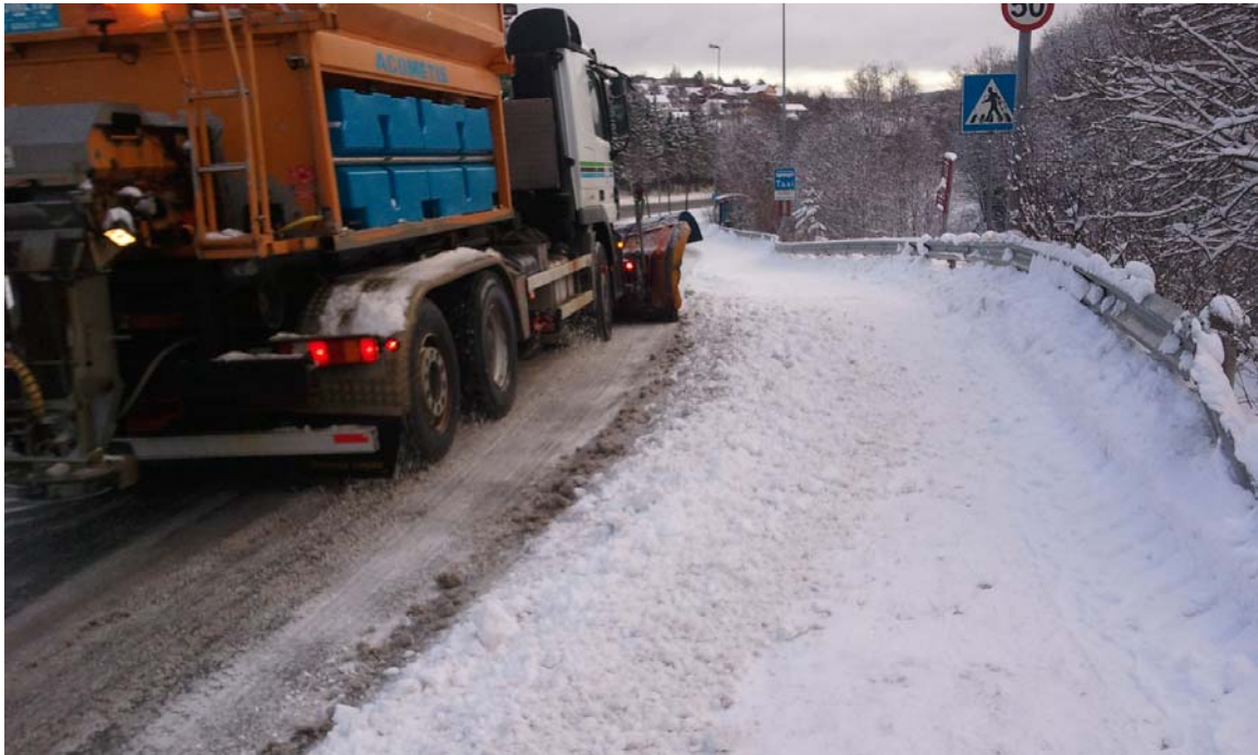
Figur 1. Saltbil i gang med etterrydding av kollektivfelt (Torbjørn Bratts veg, 7. desember 2011)
